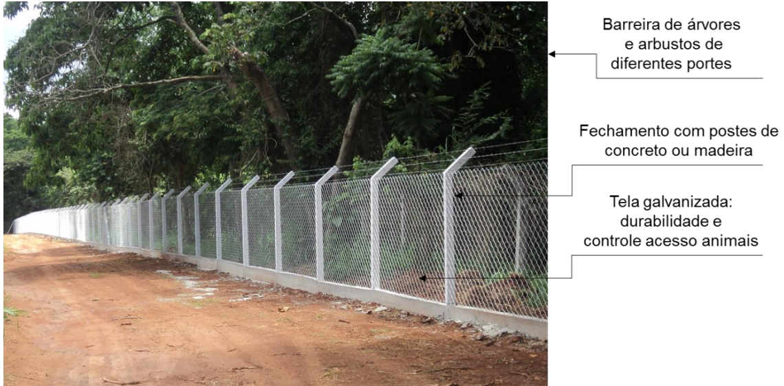
Figura 30 – Isolamentos da área: físico (cercamento) e visual (barreira vegetal)
