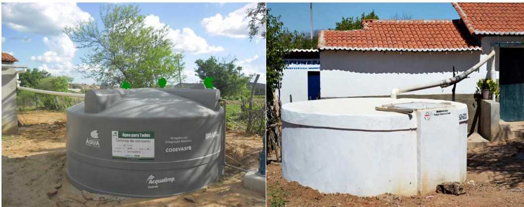
Figura 15 – Exemplos de cisterna em polietileno e em concreto
